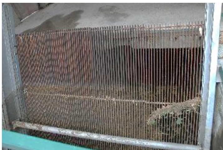
Figura 89: griglia subverticale a protezione del pozzetto di carico
