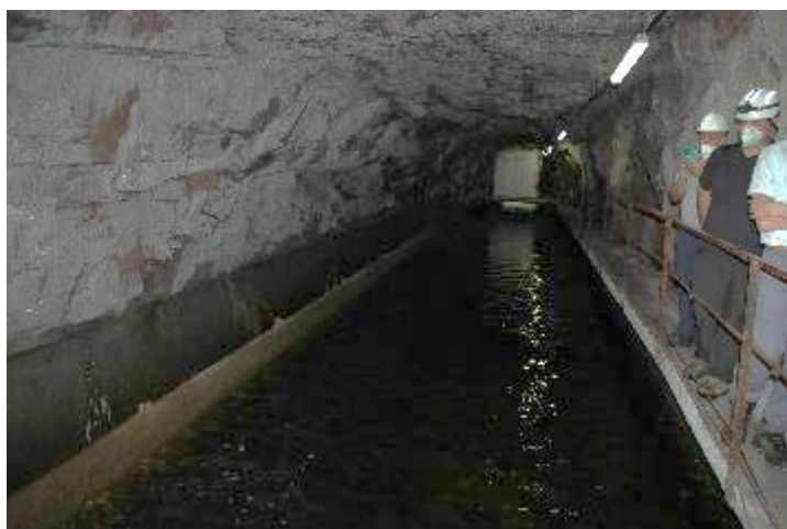
Figura 48: vasca dissabbiatrice in caverna con sfioratore laterale
