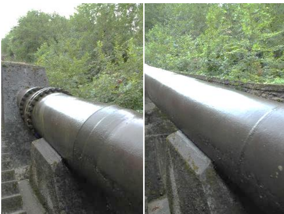
Figura 103: condotta forzata all'aperto, particolari ancoraggio e selle
