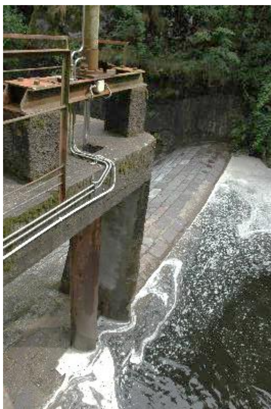
Figura 43: vista della paratoia di sghiaio e della griglia di presa
