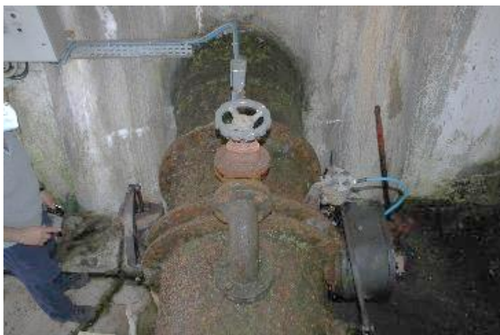
Figura 110: valvola a farfalla in modesto stato di conservazione
