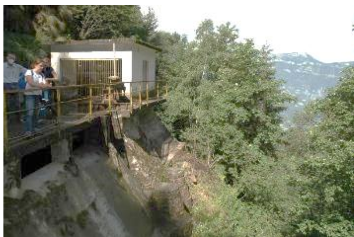
Figura 59: vista del dissabbiatore con sfioratore laterale
