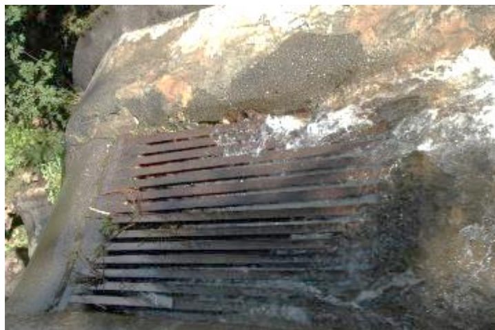
Figura 57: griglia suborizzontale di captazione
