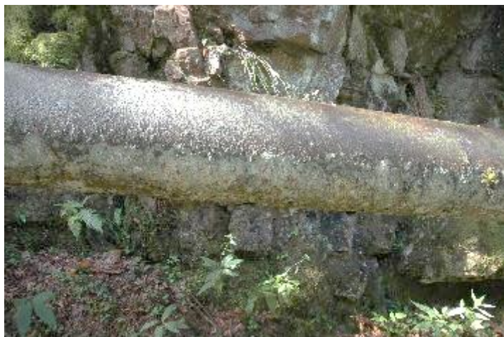
Figura 67: stato di ammaloramento condotta
