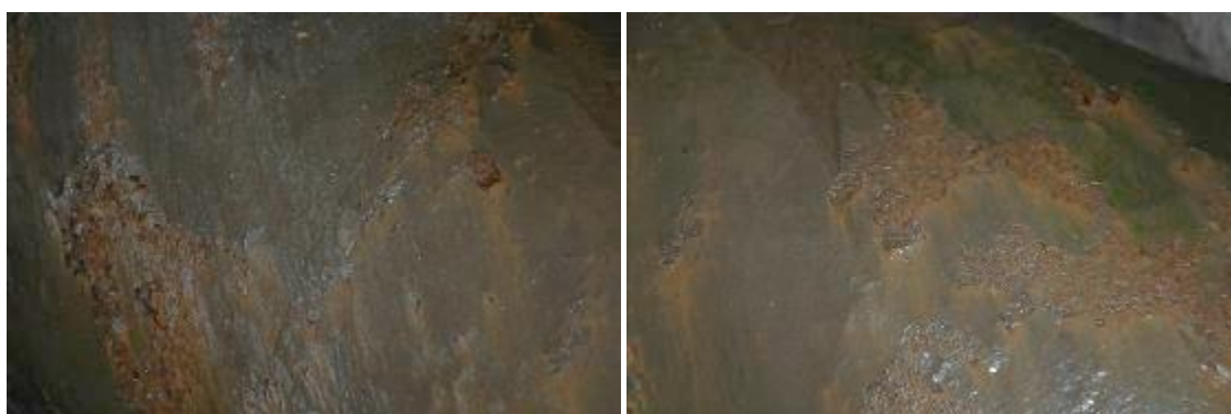
Figura 105: dettagli dell'arrugginimento della condotta
