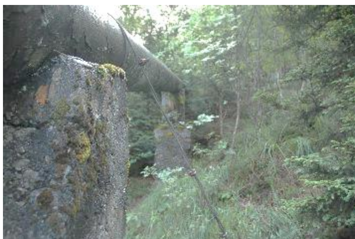
Figura 69: vista del blocco di sostegno in cls parzialmente degradato
