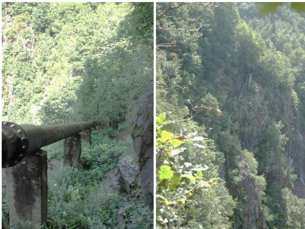
Figura 72: tratti della condotta an andamento quasi verticale
