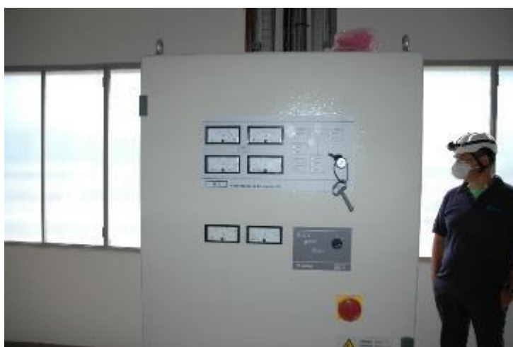
Figura 128: quadro generale sala batteria
