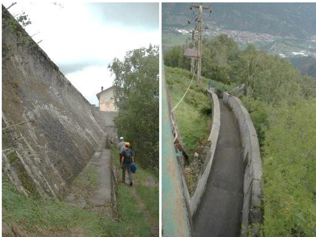
Figura 92: vista del manufatto di contenimento della vasca di carico e del canale di scarico collegato allo sfioratore di superficie e allo scarico di fondo
