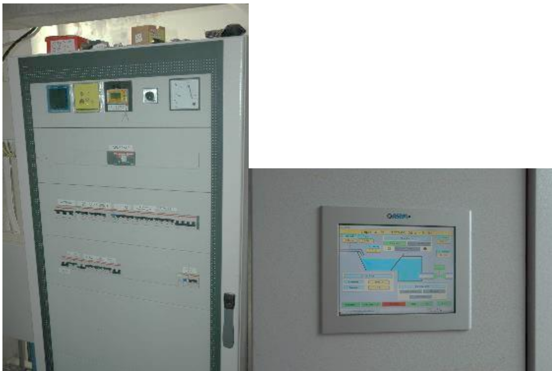
Figura 93: quadro generale organi di controllo bacino e display di interfaccia
