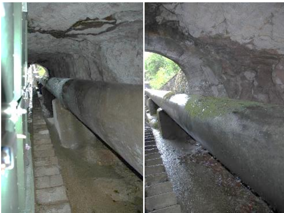
Figura 102: condotta forzata in galleria, vista dal piano inclinato
