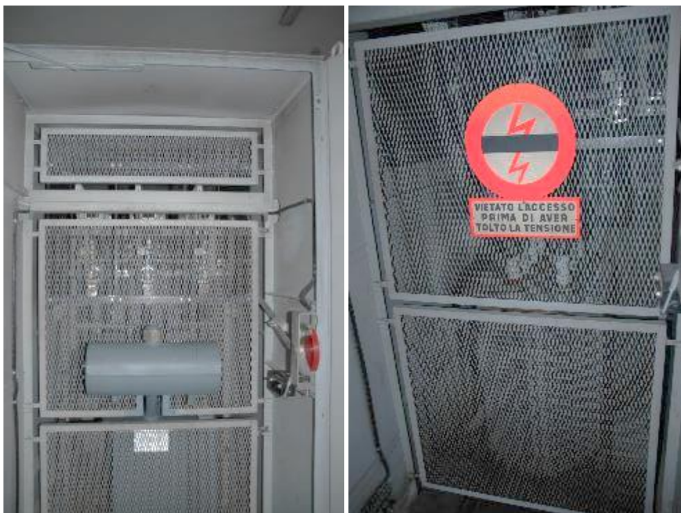
Figura 132: cabina elettrica: trafo servizi ausiliari 100 kVA e trafo vasca di carico 75 kVA
