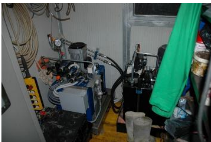
Figura 52: centralina oleodinamica per regolazione paratoia
