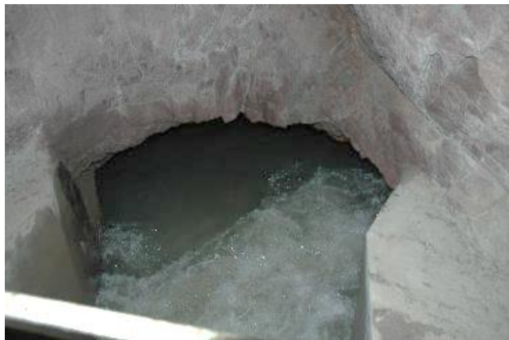
Figura 137: scarico con stramazzo nel canale di adduzione Paravasio
