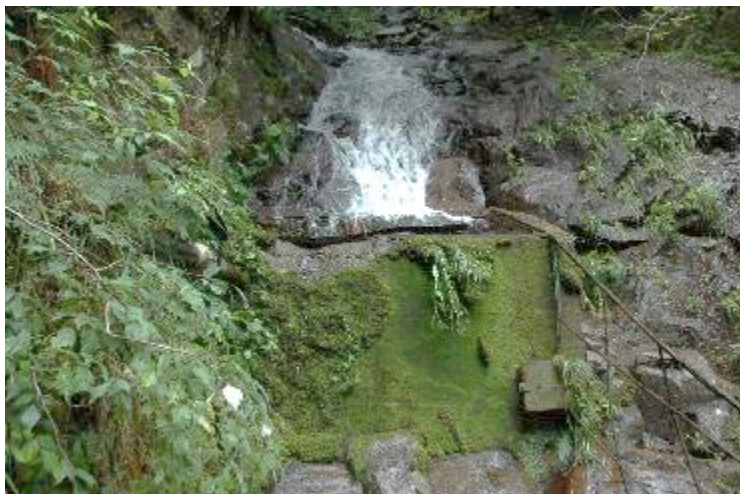
Figura 54: opera di presa con vista della griglia inclinata
