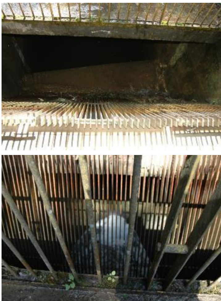
Figura 64: griglia metallica di filtrazione subverticale installata al termine del dissabbiatore
