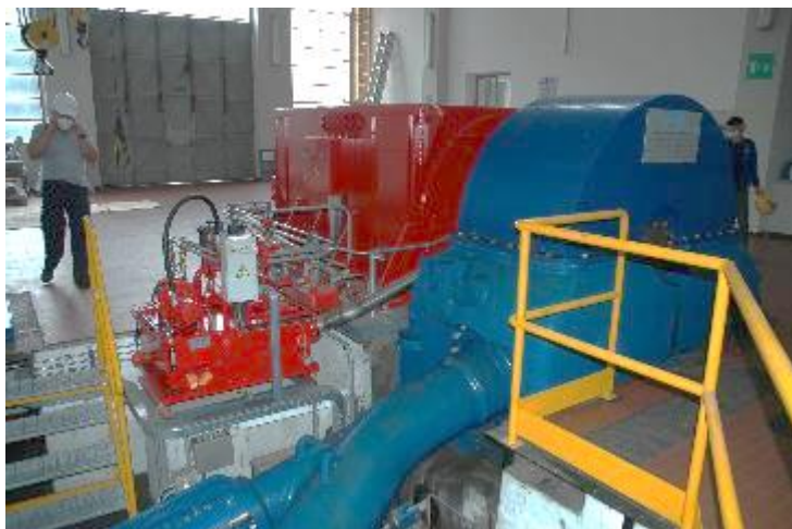
Figura 118: vista del gruppo 1: turbina pelton e alternatore
