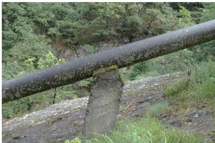
Figura 70: vista di un blocco di sostegno della condotta
