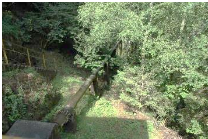
Figura 65: partenza della condotta forzata dall'opera di presa
