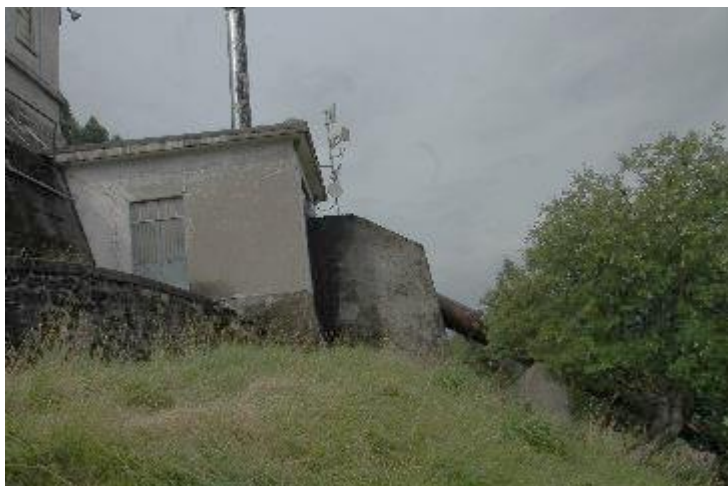
Figura 108: fabbricato camera a valvole e partenza della condotta forzata
