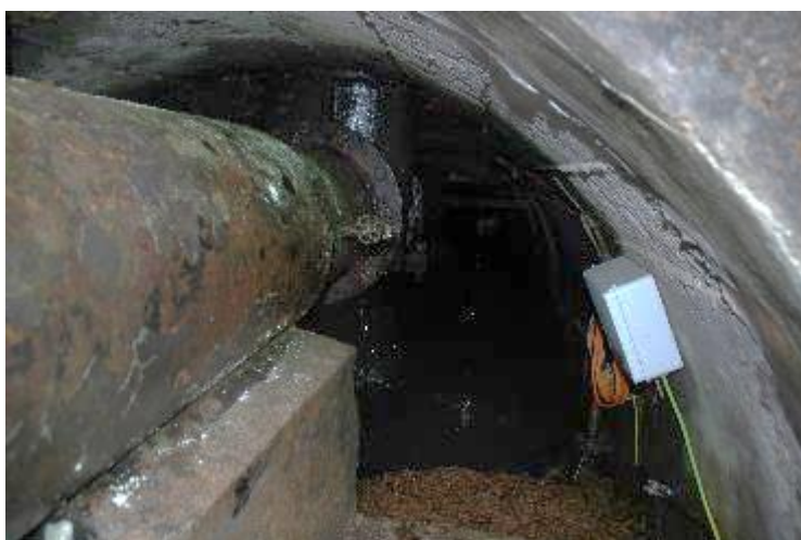
Figura 77: ingresso della condotta nel manufatto di scarico
