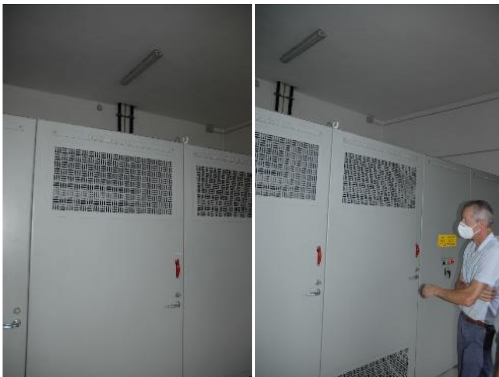
Figura 131: cabina elettrica: trafo servizi ausiliari 100 kVA e trafo vasca di carico 75 kVA
