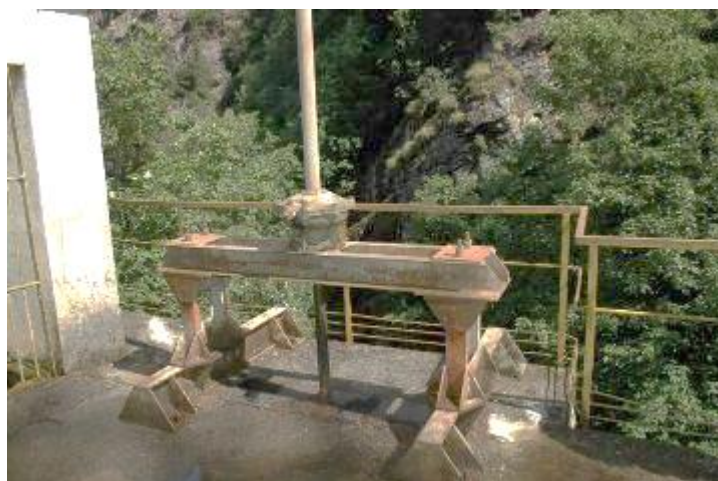
Figura 61: paratoia di sghiaio del dissabbiatore
