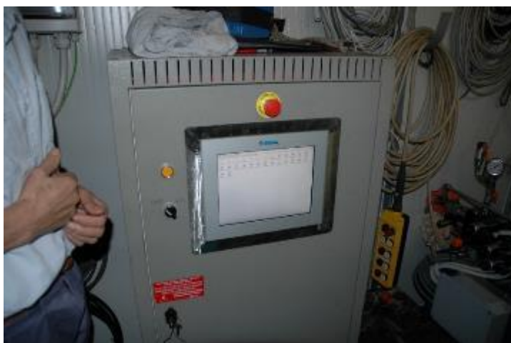
Figura 51: strumentazione di regolazione organi opera di presa
