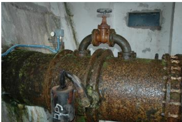
Figura 109: valvola a farfalla in modesto stato di conservazione
