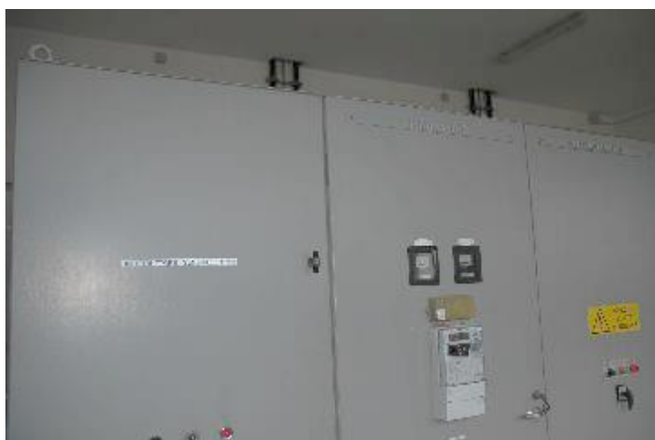
Figura 129: cabina elettrica AT: interruttore generale e quadri gruppo 1
