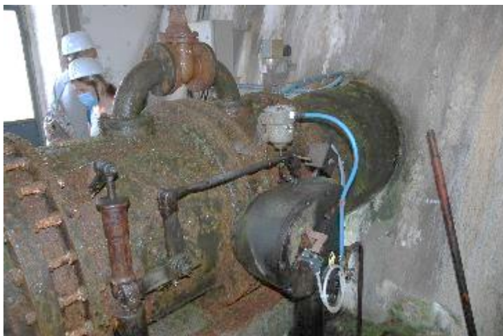
Figura 111: valvola a farfalla in modesto stato di conservazione
