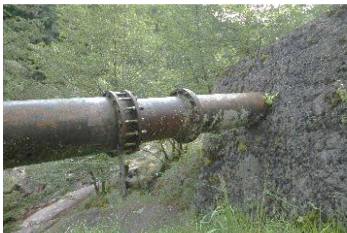
Figura 71: blocco di ancoraggio e condotta forzata
