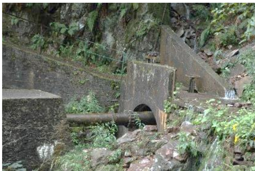
Figura 75: manufatto di scarico della condotta forzata nella galleria di derivazione principale
