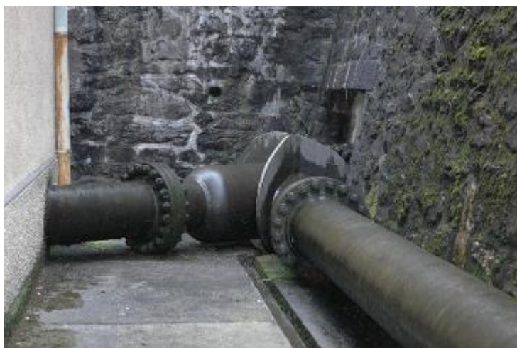
Figura 112: diramazione della condotta forzata all'ingresso della centrale
