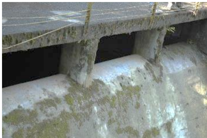
Figura 60: sfioratore laterale del manufatto dissabbiatore
