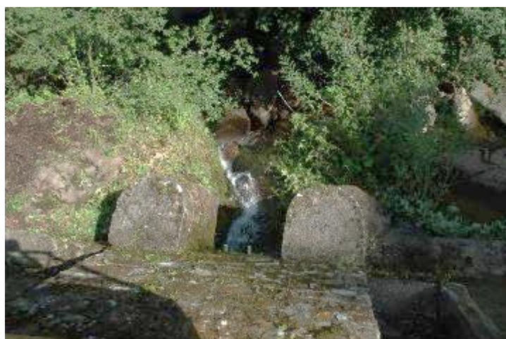
Figura 62: il rilascio del DMV dalla paratoia di sghiaio del dissabbiatore
