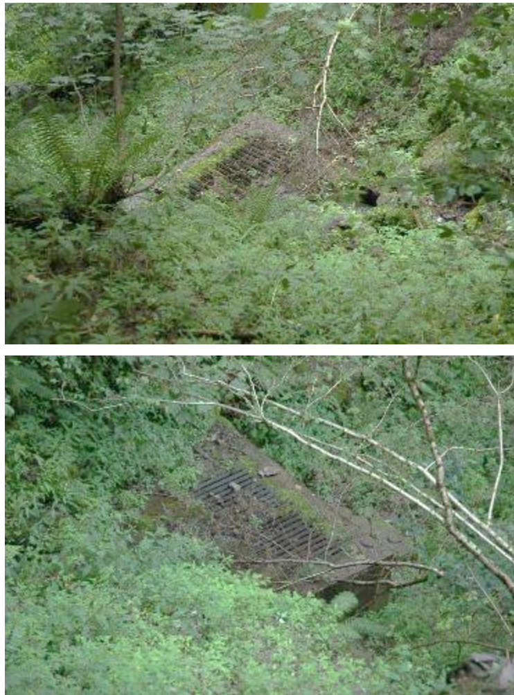
Figura 55: manufatto di presa con griglia suborizzontale
