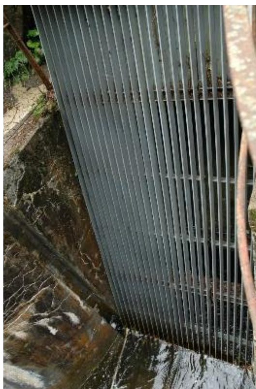
Figura 43: vista della paratoia di sghiaio e della griglia di presa
