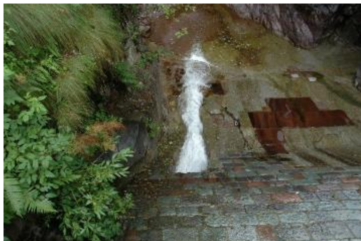
Figura 44: dettaglio del rilascio del DMV
