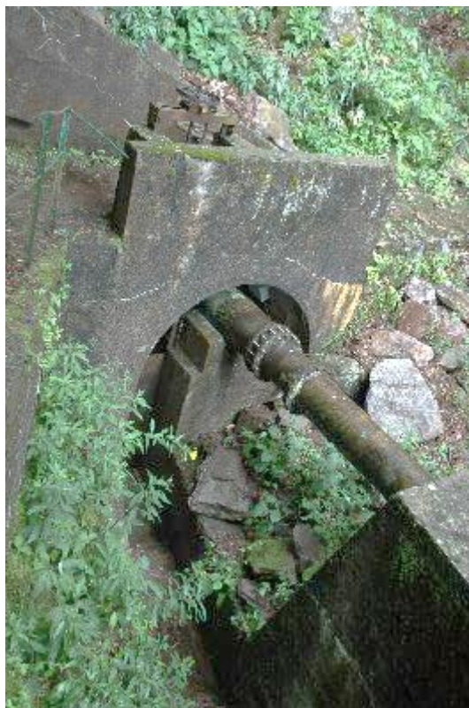
Figura 76: ingresso della condotta nel manufatto di scarico
