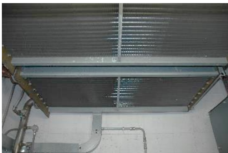
Figura 126: sistema raffreddamento con scambiatori
