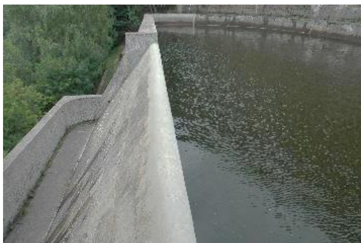
Figura 83: vista dello sfioratore di superficie
