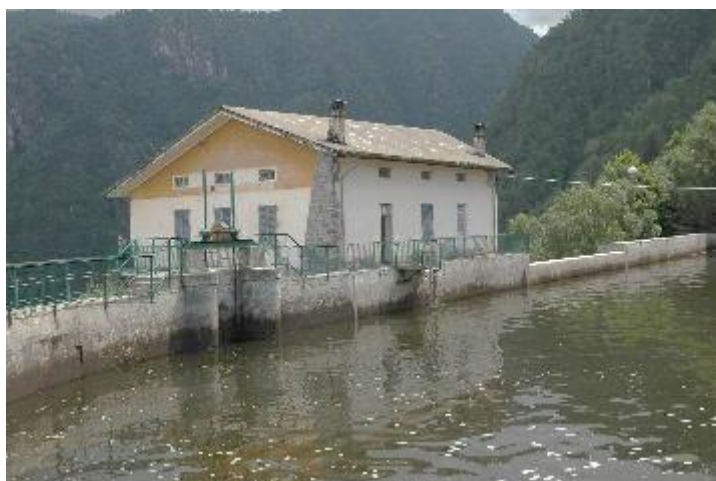
Figura 86: casa di guardiania e paratoia dello scarico di fondo
