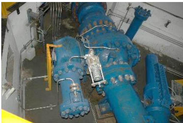
Figura 119: punto di ingresso in centrale della tubazione di alimentazione della turbina
