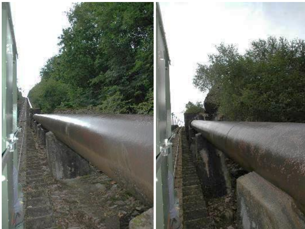
Figura 106: condotta forzata all'aperto, vista dal piano inclinato
