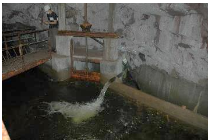
Figura 49: vista della paratoia di sghiaio del dissabbiatore e immissione del tubo dalla presa Valletta
